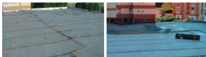
Rehabilitación sobre hormigón o antigua impermeabilización.
