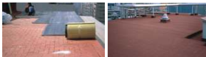
Rehabilitación sobre baldosas.
