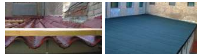
Rehabilitación sobre cubiertas de fibrocemento.
